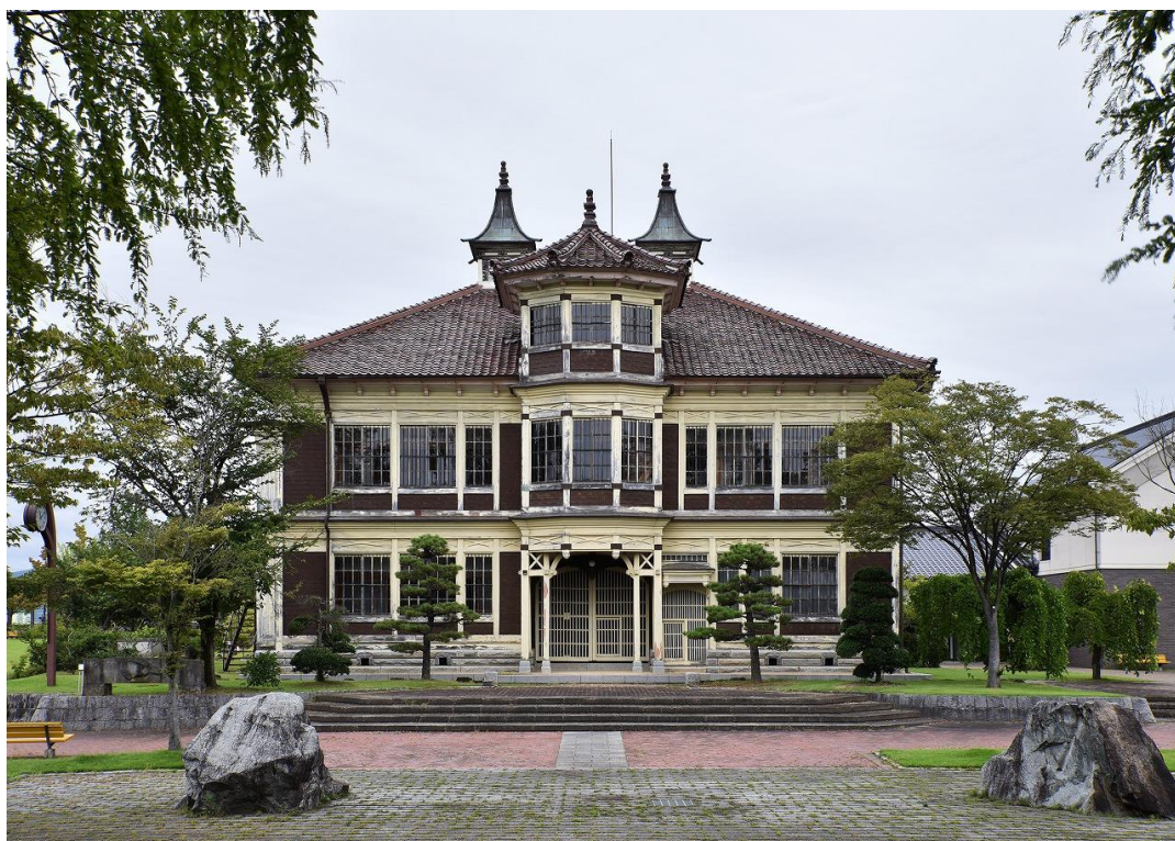
写真1：旧亀岡家住宅（1904年、1995年に福島県伊達市に移築、国指定重要文化財） 正面中央の八角形の塔屋、二基の尖塔や玄関まわりに洋風を感じさせる。内部は純和風の書院造り。施工は地元の大工、小笠原國太郎、設計は江川三郎八が関わったとされる。江川にとっては数少ない個人邸の例。 撮影：小野古彦
