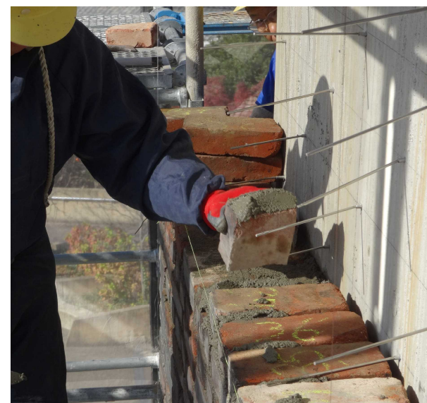
6. 既存煉瓦を元の位置に張り付ける
