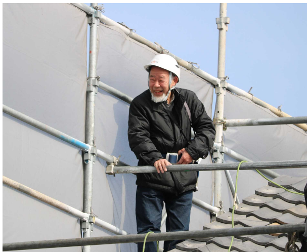
瓦施工を見守る山田脩二さん
