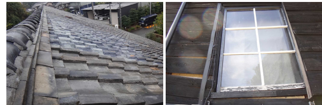
建屋調査の様子
