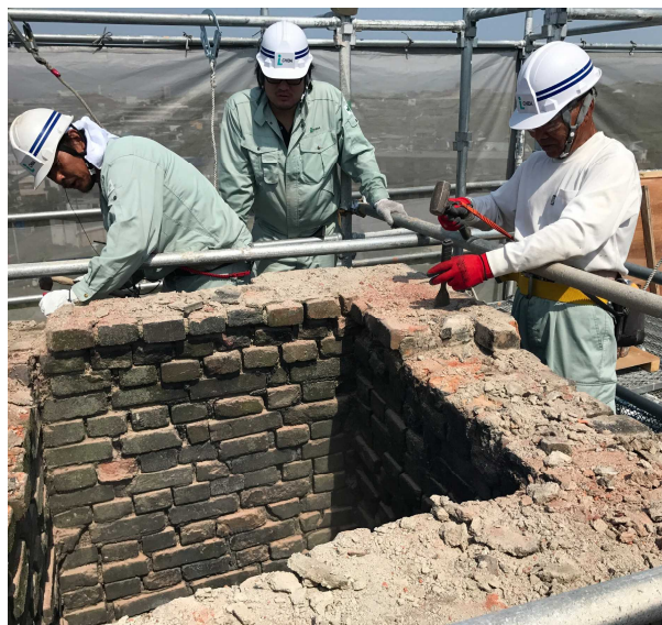
2. 既存煉瓦煙突を解体
