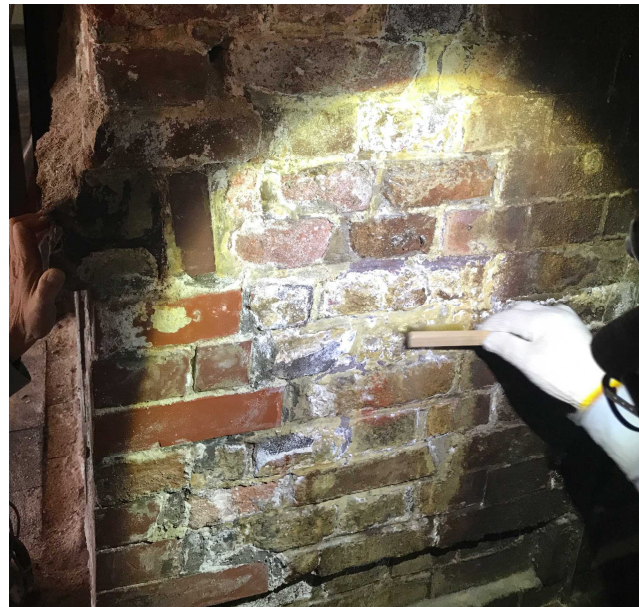
窯入口の塩類風化の様子 （白華現象が起こっている）
