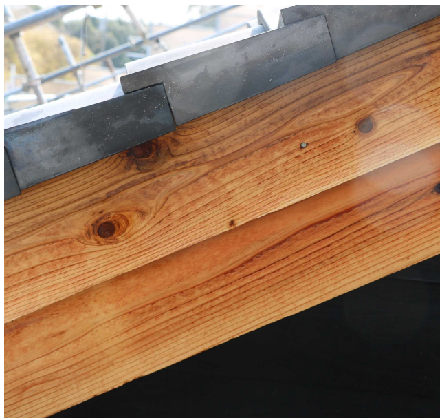
浮づくり処理後の表面
