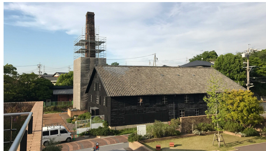
煙突保全工事開始の様子
