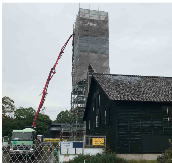
5. 鉄筋コンクリートの煙突構築
