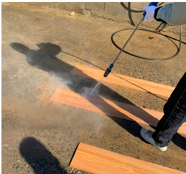
高圧洗浄水による浮づくり処理
