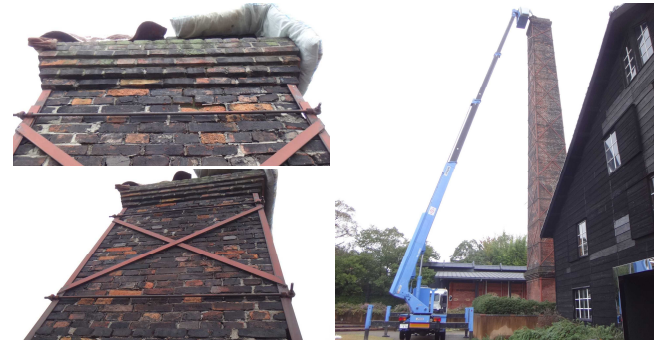
煙突調査の様子
